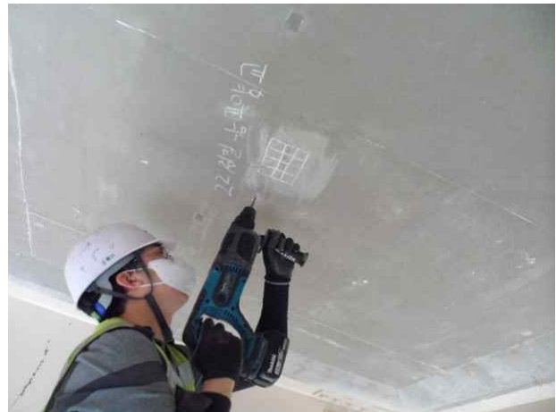
탄산화깊이 측정 현황
